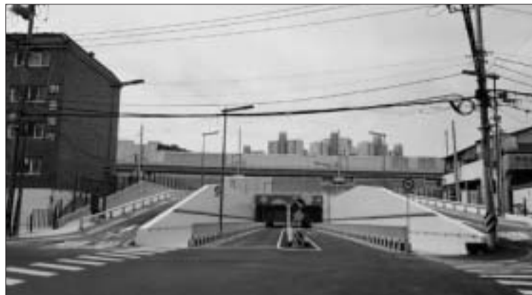
경부고속철도변 정비사업 인동지하차도 확장과 은어송 지하차도 신설 공사 현장 모습.
