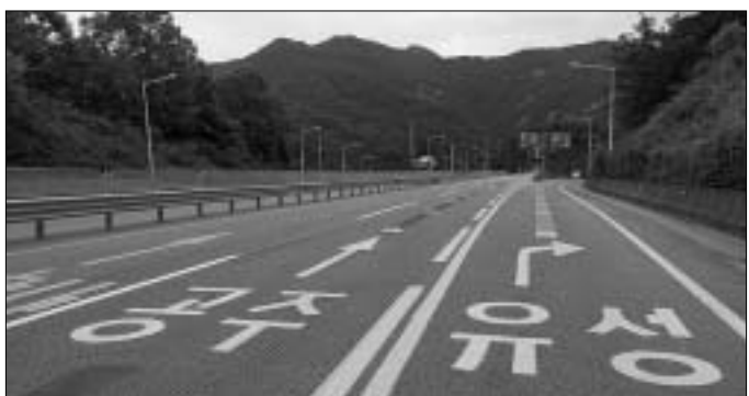
공주서, 교통사고 예방 위해 칼라레인(차선지나표지) 설치 공주경찰서(서장 강복순)는 노산국토관리사무소와 협업하여 교통사고 예방을 위해 차량 통행이 많고 길이 복잡한 정안C교차로, 삼계교차로(대전시계), 장암교차로 등 도로에 칼라레인을 설치했다.
